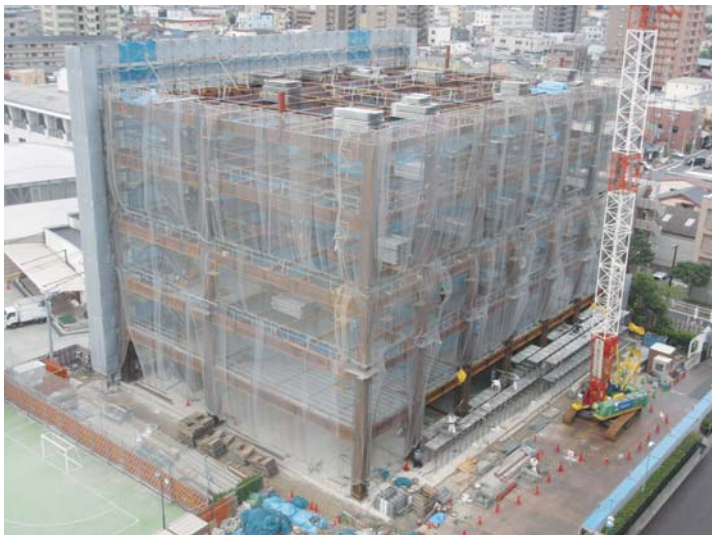
鉄骨建方が完了した新棟
