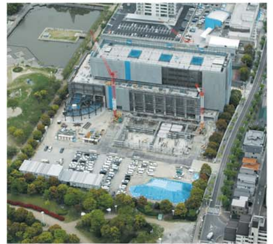
▲ 白鳥学舎工事
